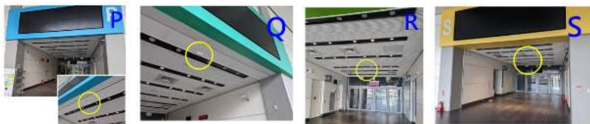
圖 14. Bio-Asia 展區進出人流影像辨識裝置的配置
